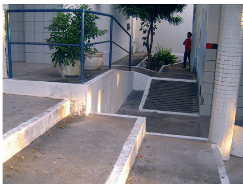
Foto 2: Rampas de acesso
