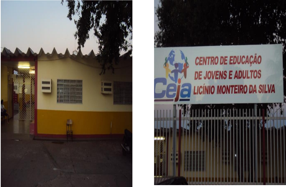
Fig. 1 — Fachada do CEJA “Licínio Monteiro da Silva”.
