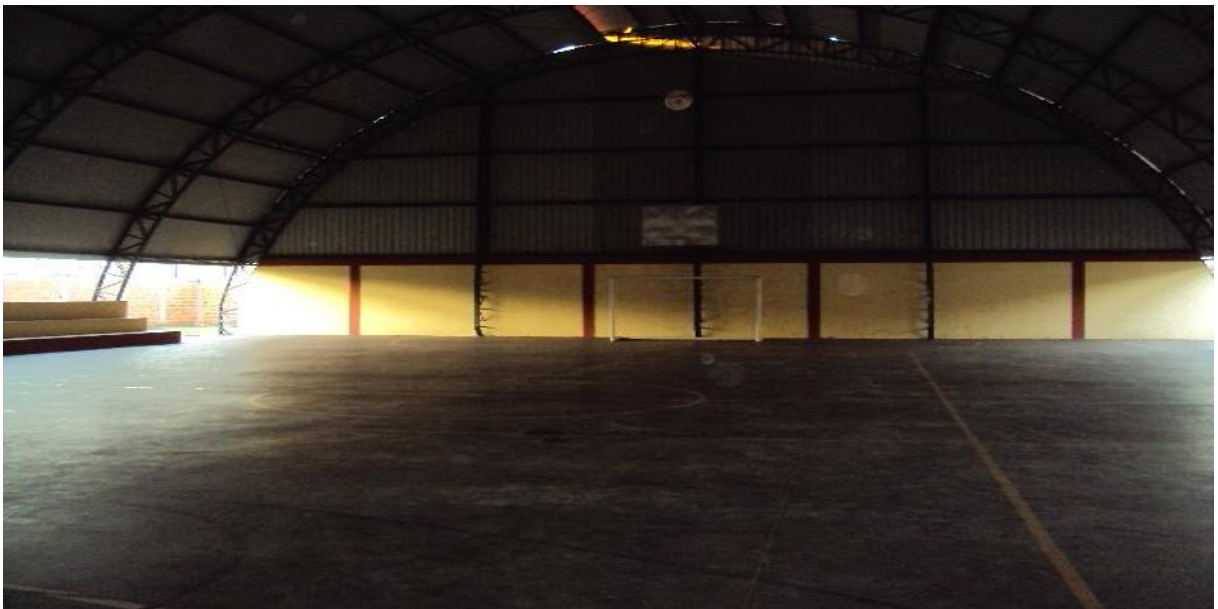
Fig. 3. Vista interna da quadra.
