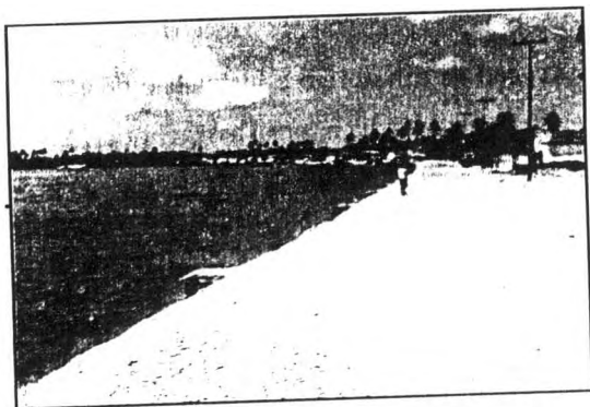
2. Vista do alongamento do cais do bairro de Conceição, que margeia expressivo trecho do bonito rio Santa Rosa
